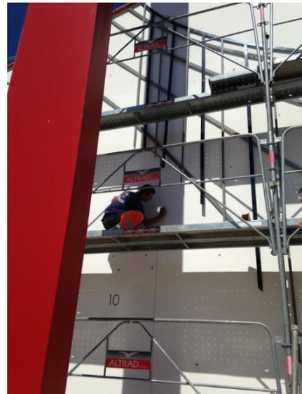
Fig 5 : Photo du 13 mai 2013 : tout le cadran a été démonté. On matérialise la tache de lumière projetée par l'ocillon lorsqu'elle passe à la verticale du pied du style droit fictif
