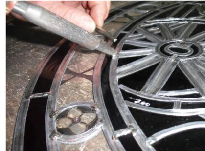
Le chevauchement des ailes des plombs est recouvert et dissimulé sous l'étain. La soudure est légèrement bombée sans être trop grosse. La deuxième face du panneau est ensuite contre soudée à l'exception du plomb d'entourage qui ne l'est pas.
